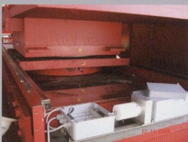
Système de contrôle pour surveillance constante en ligne de la déformation des appuis du Pont du 25 avril sur le Tage à Lisbonne (Portugal)
